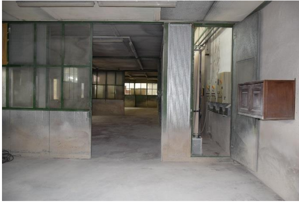
Cabina verniciature Piano Terra
