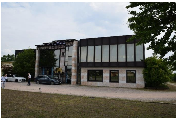
Prospetto principale lato Nord
