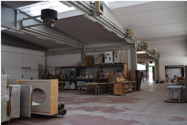
Zona lavorazioni Piano Terra
