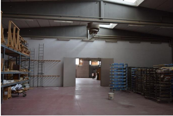
Zona lavorazioni Piano Terra
